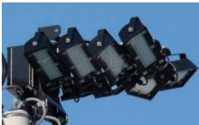
8 ledmodules worden als 1 armatuur berekend en op locatie niet na-gericht per module.
