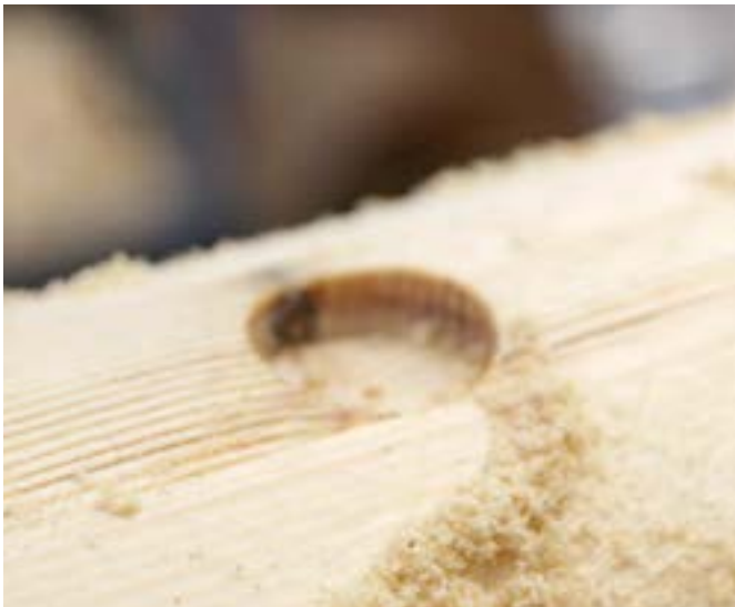
Uitboren kwast en aanbrengen houten plug
