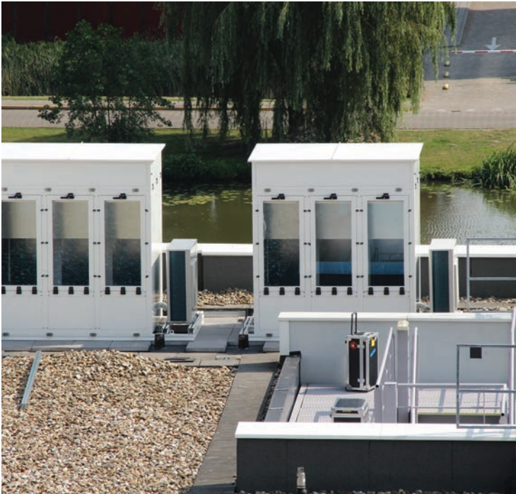
Behuizing tijdens de opbouw op het dak.
